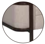
DETALLE ESTRUCTURA METÁLICA
